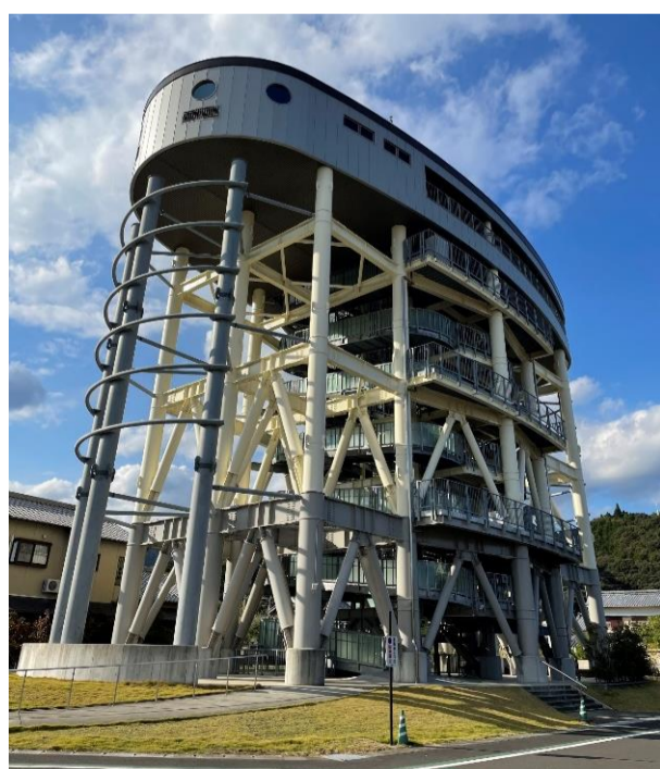
佐賀地区津波避難タワー
