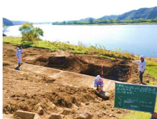
既設コンクリート取壊し寸法確認
