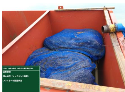
フィルターの設置
