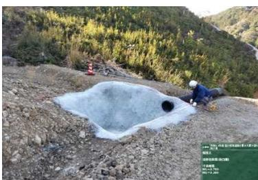
▲排水管・沈砂池(2か所)の設置
